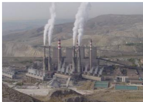
チャイラハン発電所
