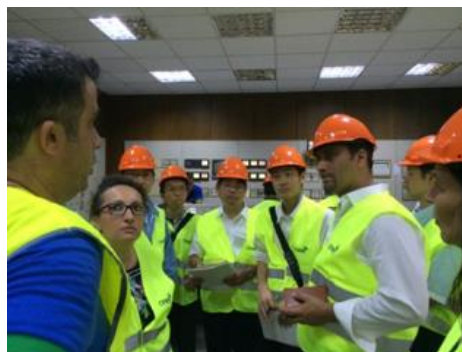
現場設備の状況確認
