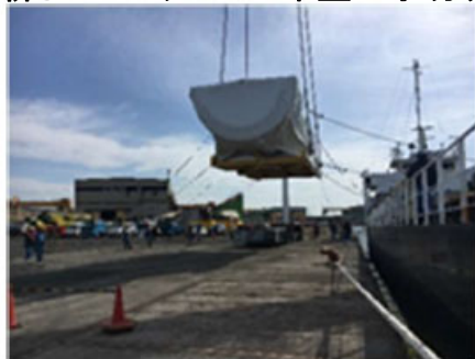
新しいガスタービン車室の水切り
