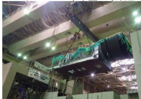
新しいガスタービン上半車室の吊り込み作業
