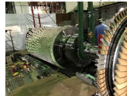
新しいガスタービンロータの吊り込み作業
