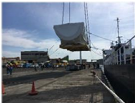
新しいガスタービン車室の水切り
